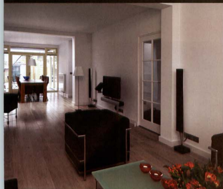
Massieve Bamboe vloer, 15 mm dik, gelegd op Elastilon Strong. Foto's gemaakt tijdens strenge vorstperiode met lage relatieve luchtvochtigheid.
